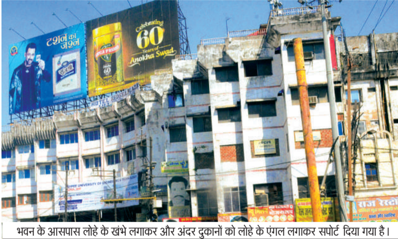
भवन के आसपास लोहे के खंभे लगाकर और अंदर दुकानों को लोहे के एंगल लगाकर सपोर्ट दिया गया है।
